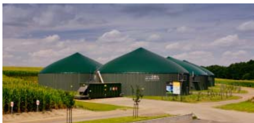
G. Ponsin, MT-Energie GmbH
